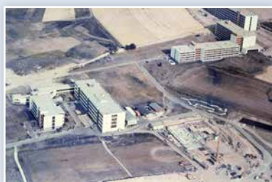
Baubeginn des Berufsförderungswerkes Eckert in Regenstauf.
