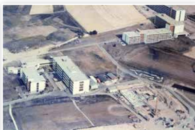
Baubeginn des Berufsförderungswerkes Eckert in Regenstauf.
